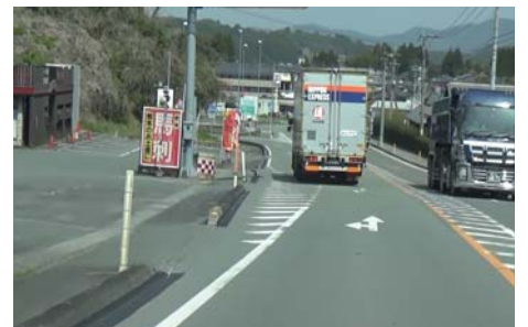
県道 玉名山鹿線 単県道路施設修繕(防草対策)工事 他合併
