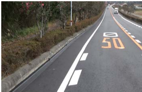
国道266号 熊本県天草市河浦町 熊本県発注工事
