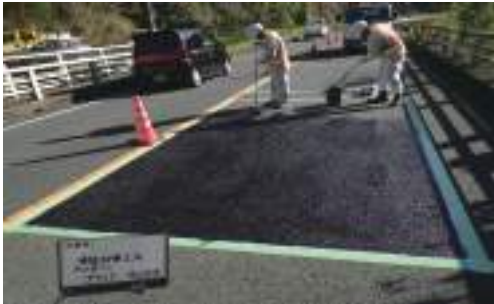
プライマー塗布
