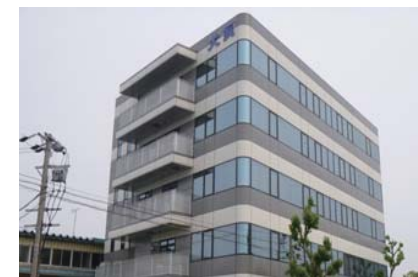
愛知県名古屋市 1社 本社ビル(2000㎡) 珉瑯(ほうろう)壁
