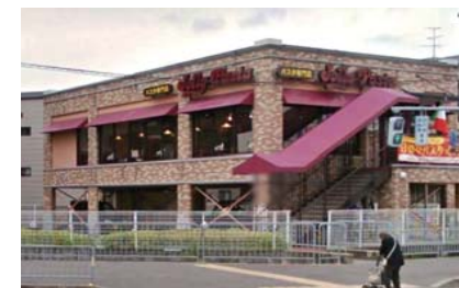
京都府京都市西京区 店舗屋上(600㎡)
