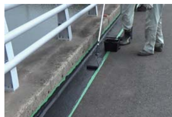
トップコート施工状況
