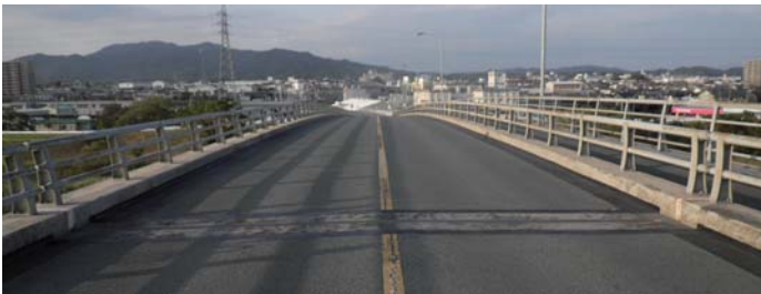
小島橋補修工事 玉名市役所発注工事（小島橋）
