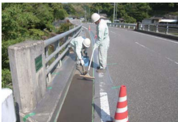
レベリング施工状況
