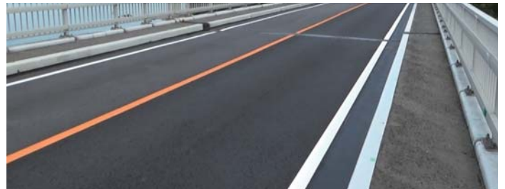
国道266号（松島橋）防災安全交付金（橋梁補修）工事 他合併 熊本県発注工事（天草五橋の5号橋）
